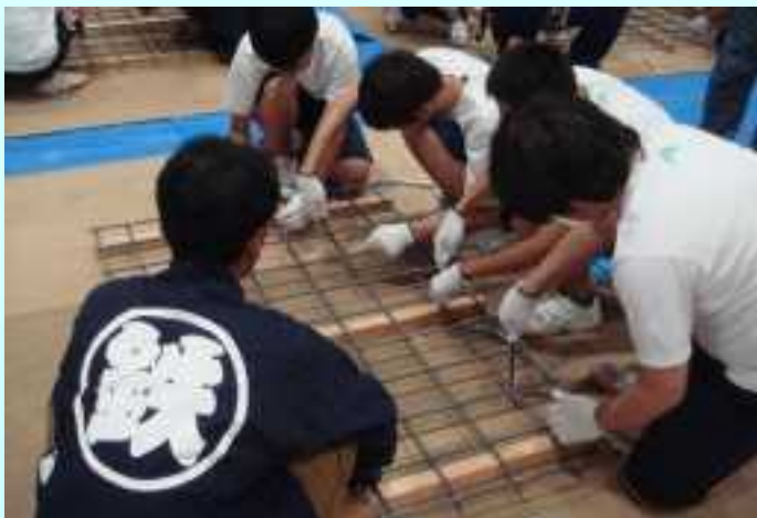
アドバイスを受けながら鉄筋結束作業に挑戦
